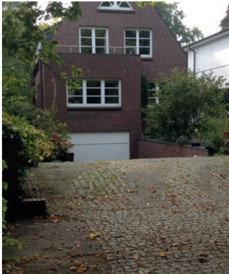
15 Garagenzufahrt mit Schutzschwelle
