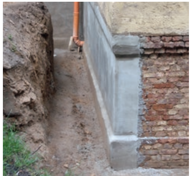
30 Wasserdichter Sperrputz
