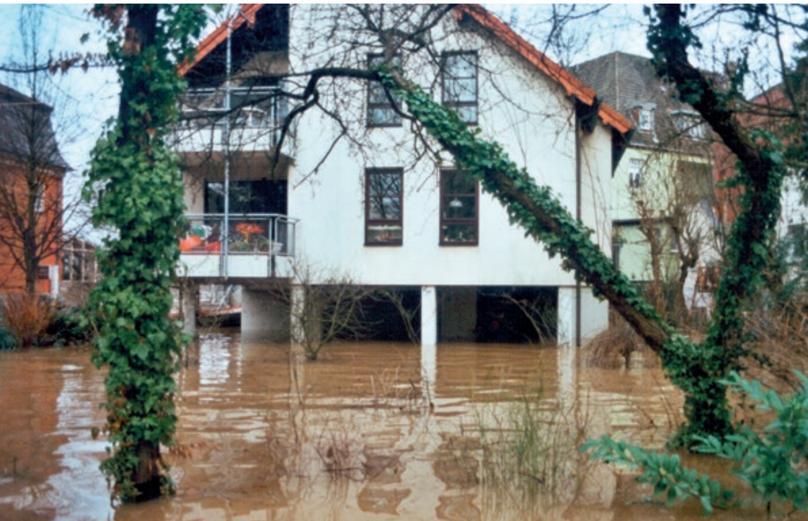
5 Überfluteter Straßenraum in Köln nach einem Starkregenereignis
