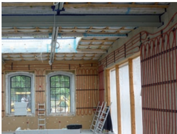
Die Wandheizung wird verlegt
