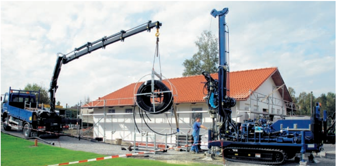
Erdsondenbohrung für eine Sole/Wasser-Wärmepumpe mit der Weishaupt Tochtergesellschaft BauGrund Süd
