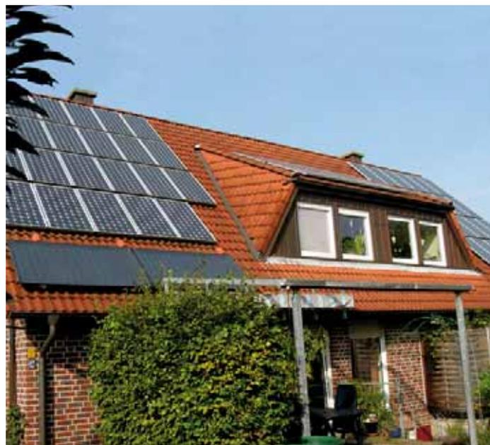
Solarenergienutzung zur Stromerzeugung oben (PV) und zur Warmwasserbereitung unten (Solar-Thermie).
