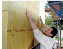
Dämmung der Außenwand
