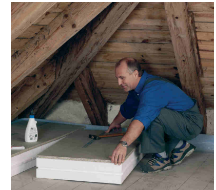
Dämmen der obersten Geschossdecke
