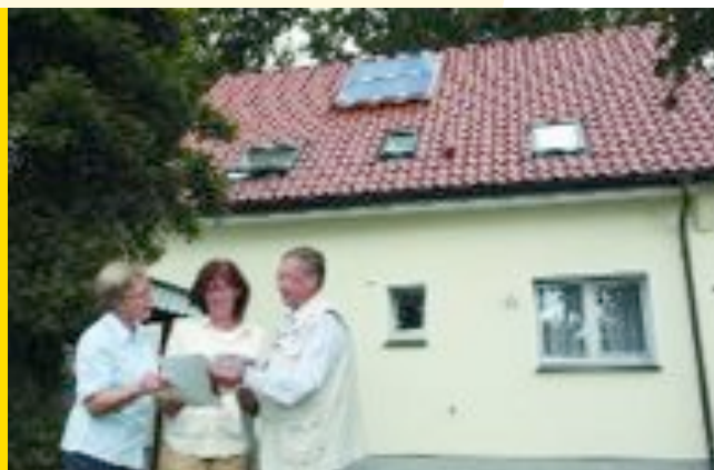
Gemeinsam mit dem Ehepaar Kaup freut sich die Architektin Brigitte Topmöller über die gelungene Sanierung; nach Abschluss der Arbeiten dokumentiert der Energieausweis den Neubaustandard des sanierten Gebäudes.
