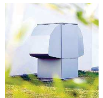
▲ Geschickte Integration einer Luft/Wasser-Wärmepumpe in die Außenanlage
