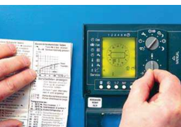
▲ Es gibt keine Vorschrift, die eine Nachtabsenkung vorseht. Allerdings sollte jede Heizung die Möglichkeit dazu haben.
