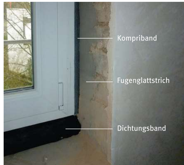
Gut vorbereitete Leibung für rundum dichte Anschlüsse
