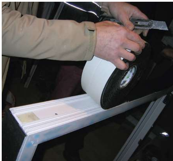
Einbau eines Multifunktionsdichtungsbandes
