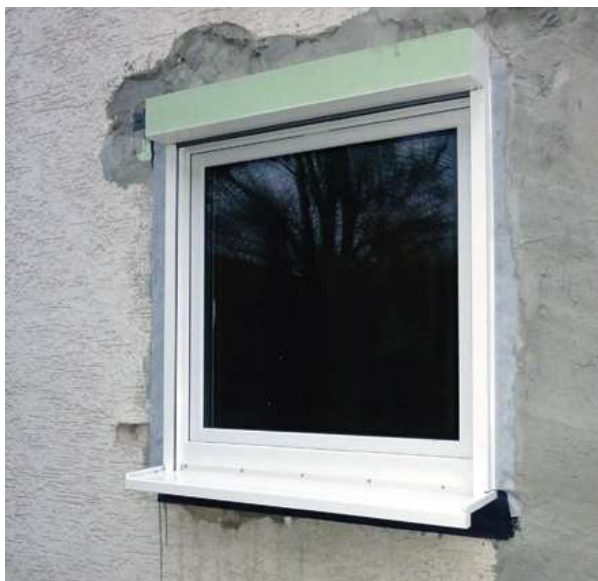
Fenster mit außenliegendem Rollladenkasten für gleichzeitige Fassadendämmung
