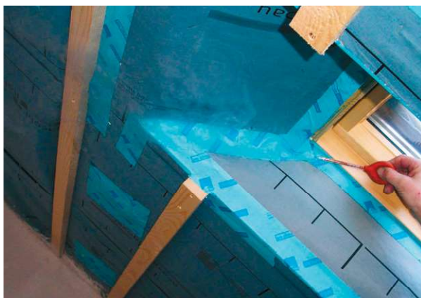
Die Dichtheit wird überprüft.
