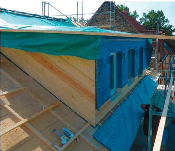
Ein neuer Aufbau der Gaube kann manchmal die bessere Lösung sein.
