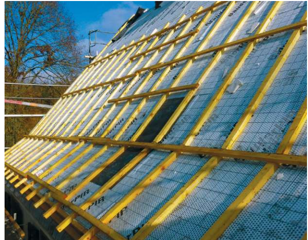
Eine Aufsparrendämmung mit Unterspannbahn vor der Eindeckung.
