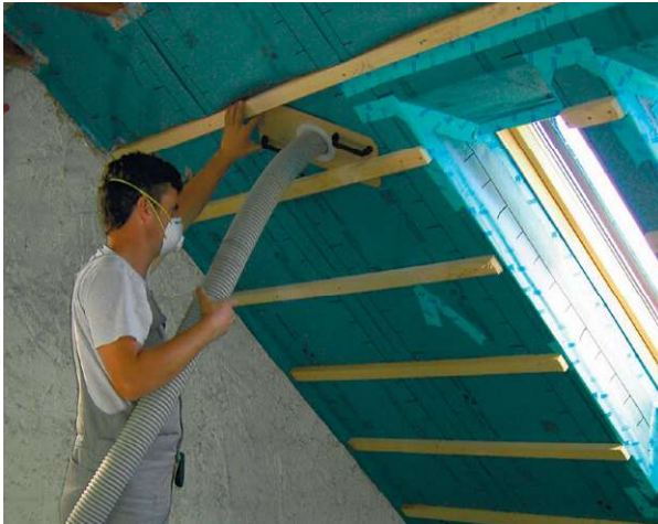
Der Dämmstoff wird eingeblasen.
