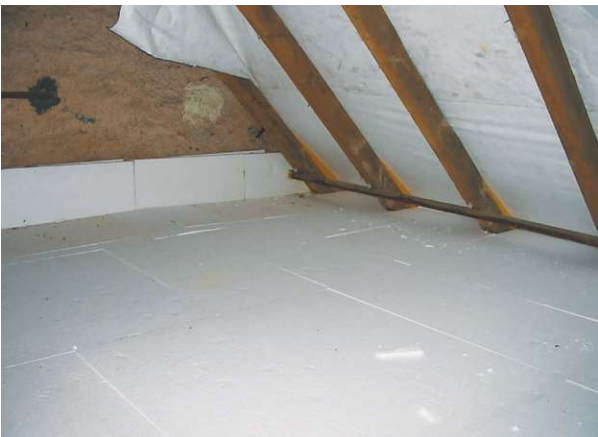
Dachbodendämmung mit Flankendämmung an der Giebelwand.
