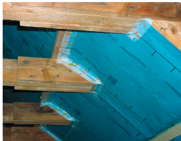
An jeden Balken muss dicht angeschlossen werden!
