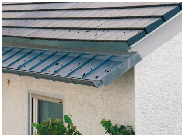
Ein neuer Dachüberstand aus Zinkblech.
