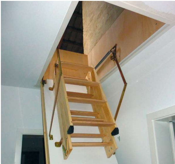
Eine neue, gedämmte Bodentreppe.
