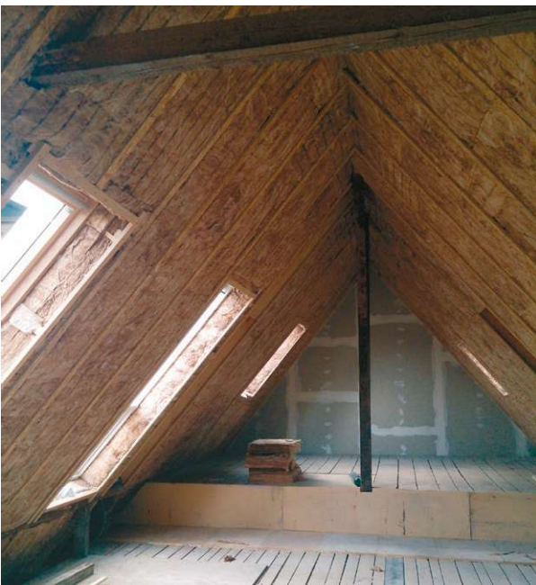
Zwischensparrendämmung mit Steinwolle
