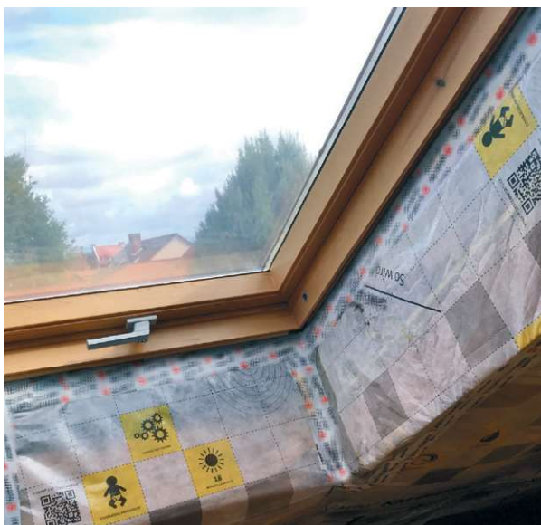
Die Folie ist dicht am Fenster angeschlossen.
