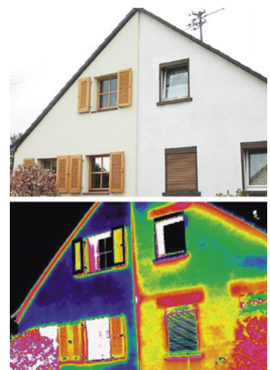
Die Thermografieaufnahme zeigt auf einen Blick, wo kostbare Energie verloren geht.
