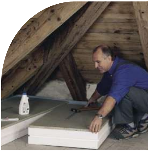
Dämmung oberste Geschossdecke
