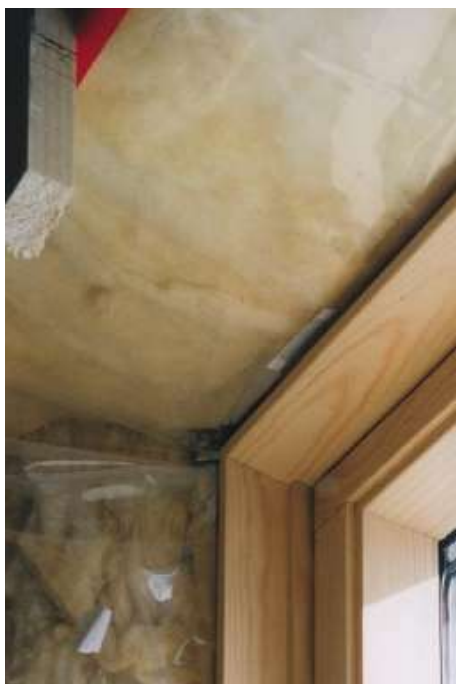
Luftdichter Anschluss eines Dachfensters mit Hilfe einer zugehörigen Schürze.
