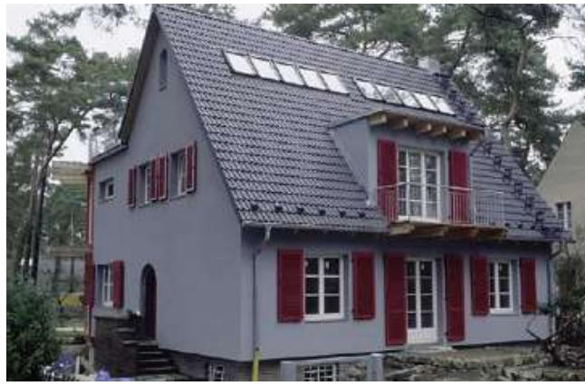
Vor und nach der Modernisierung
