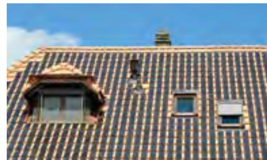
Photovoltaik-Module in Tondachziegeln
