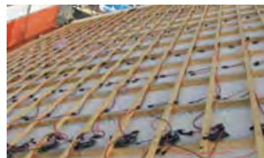
Anschluss für Photovoltaik-Module in Tondachziegeln
