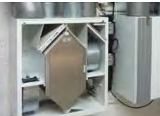
Lüftungsanlage mit Wärmerückgewinnung
