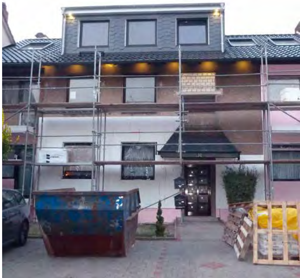
Mit einem Wärme-Dämm-Verbundsystem wird die Fassade verkleidet.
