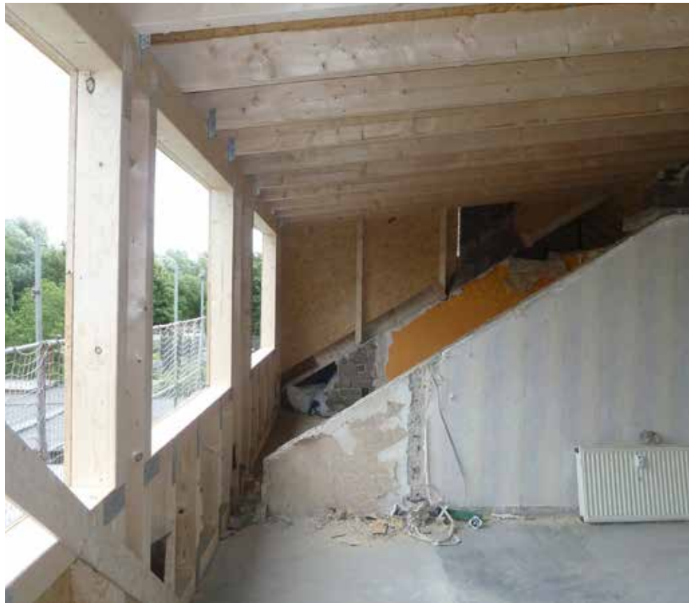
Die neuen Gauben schaffen richtig Platz, wie man noch an dem alten Mauerwerk erkennen kann.
