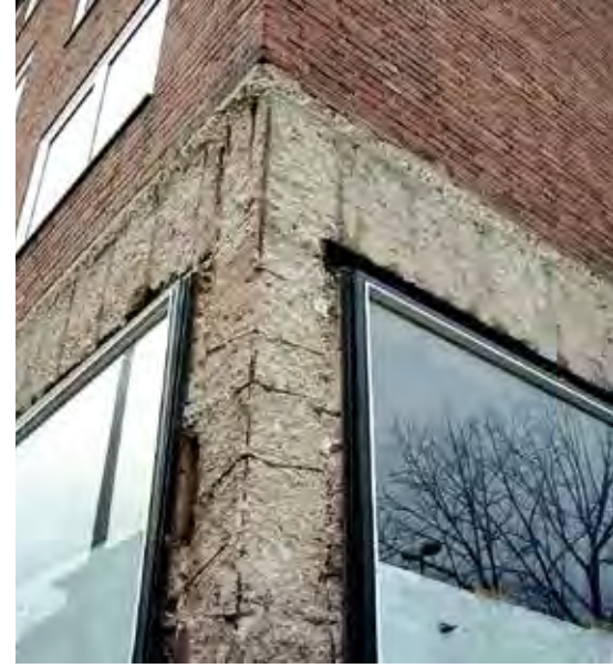
Baumängel beheben: Freiliegende Eisen können rosten und die Bau- substanz gefährden.
