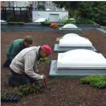
Begrünung schützt das Dach und hilft, das Mikroklima zu verbessern.
