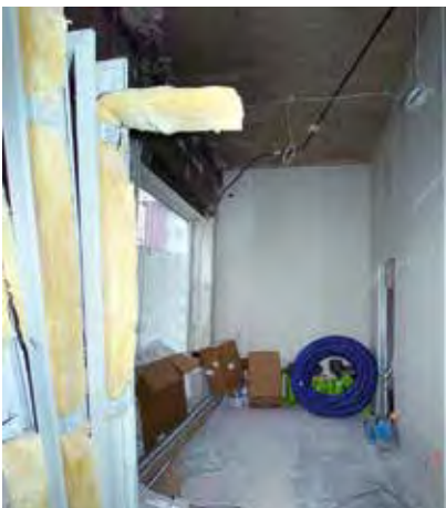
Innenausbauten und Dämmung haben bereits begonnen.
