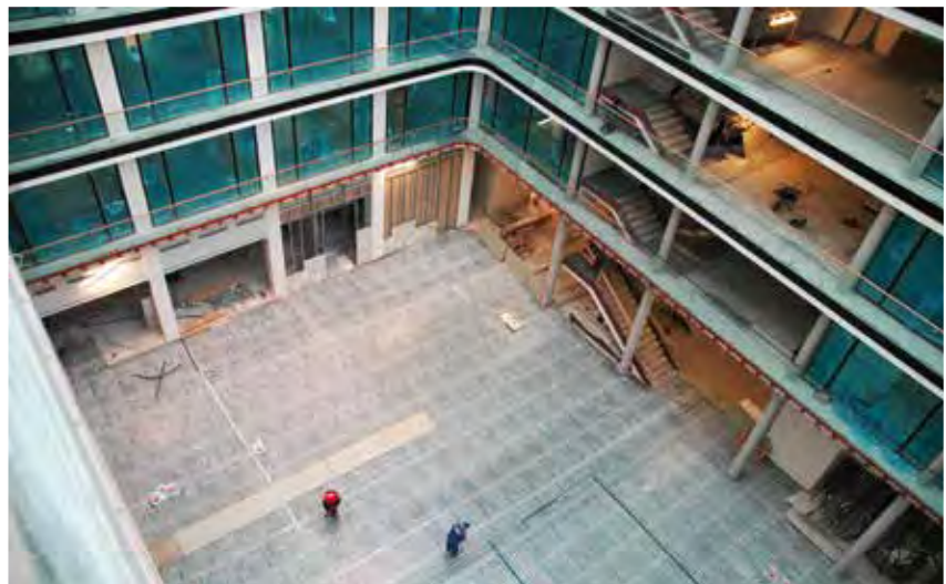
Tausende Meter Rohr wurde allein für die Fußbodenheizung im EG verlegt.
