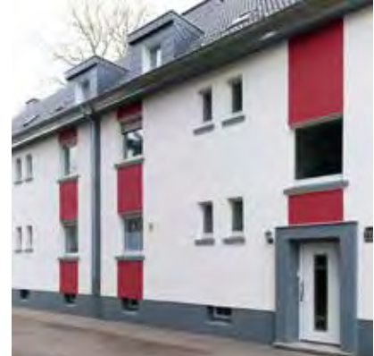
In nur zwei Monaten wurden die Mehrfamilienhäuser saniert.
