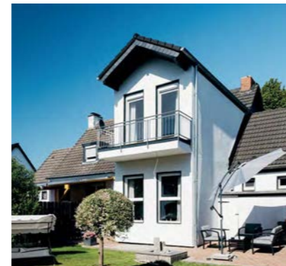
Schon zum zweiten Mal umgebaut: ein Zechenhaus in Gelsenkirchen-Bismarck.
