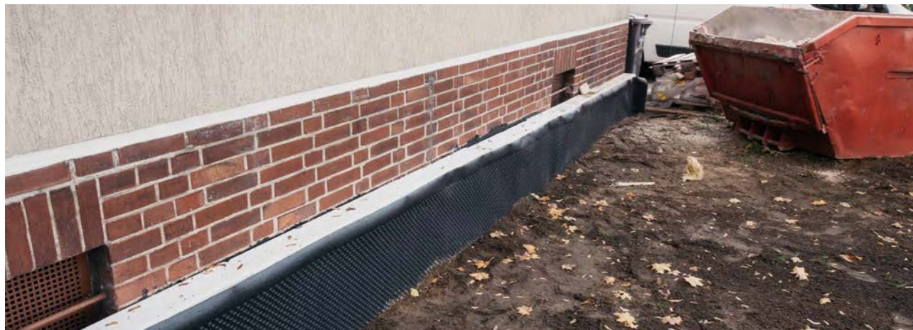
Hier wurde der Anschluss für die Fassadendämmung von der Isolierung der Keller-aussenwand aus perfekt für die Dämmung vorbereitet.
