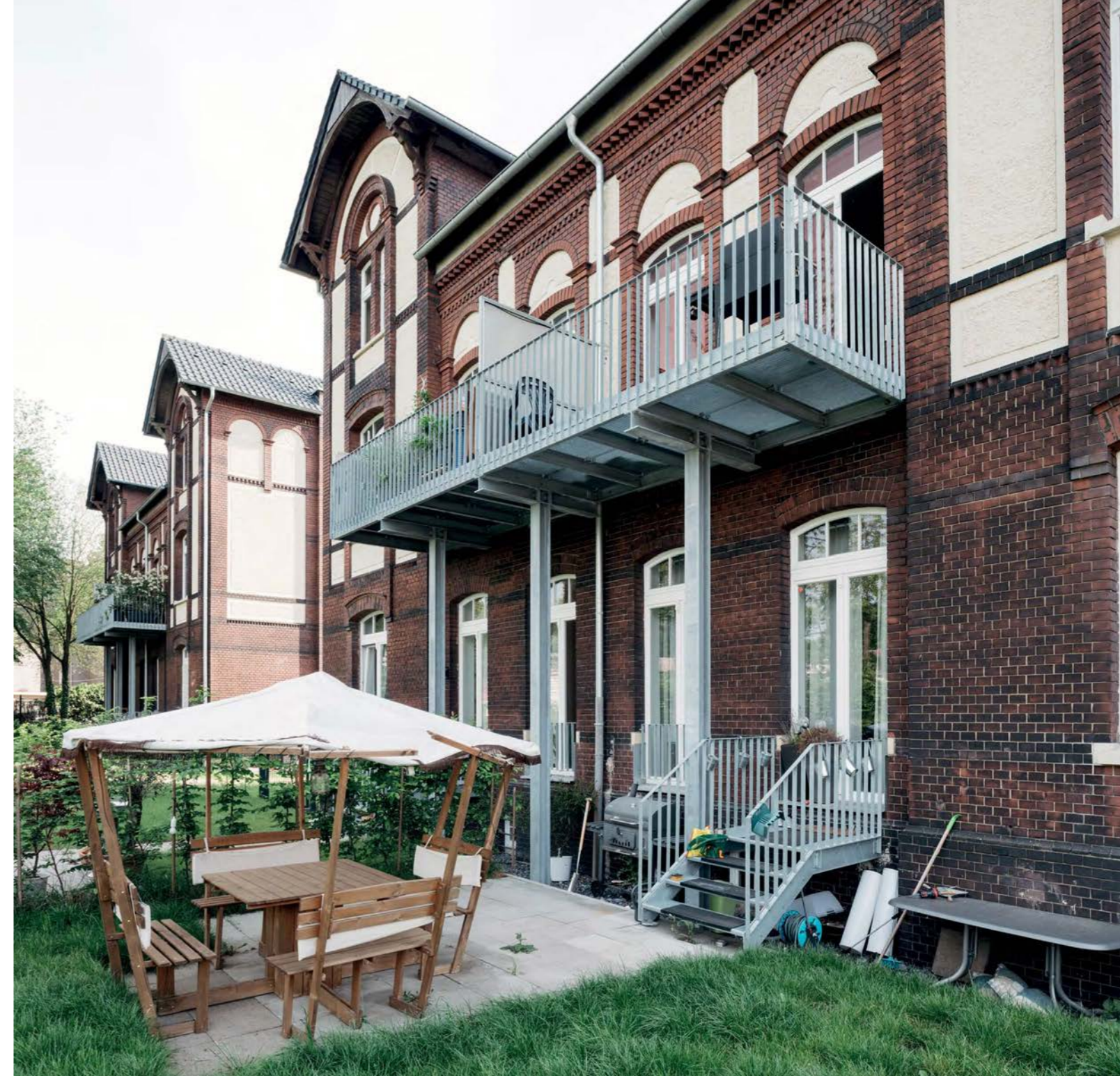
Die Anstellbalkone wurden in schlichter industrieller Bauweise gefertigt.
