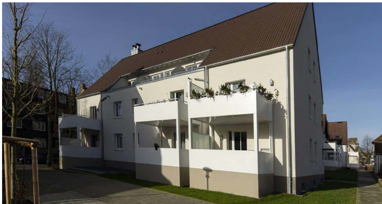
Der Neubau fügt sich harmonisch in das Ensemble ein und bietet im Keller gleichzeitig Raum für eine moderne Heizungsanlage.
