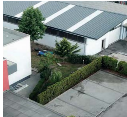
Durchdachte Lösung für eine ganzjährig nutzbare Werkstatthalle.
