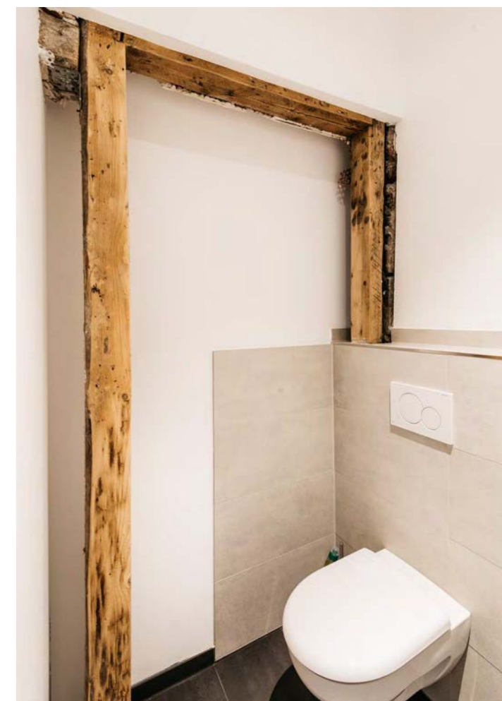
Einige der freigelegten Balken wurden nach der Offenlegung nicht mehr verkleidet. Indem sie offen sichtbar bleiben, erinnern sie an die Bauweise des Gebäudes.
