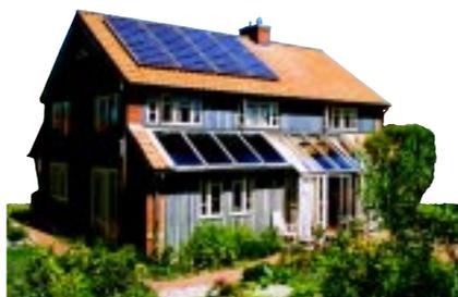
Bild 27: Photovoltaikanlage oben und thermische Solaranlage unten an einem Einfamilienhaus
