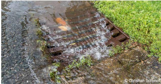
Extremereignisse sind selten, können aber jederzeit und praktisch ohne Vorwarnung auftreten. Bachdurchlässe und -einläufe, aber auch das Kanalnetz selbst sind für solche Extremereignisse nicht ausgelegt. Der Bau entsprechend großer Abwasseranlagen für kurzfristig auftretende große Wassermengen ist technisch kaum möglich.
