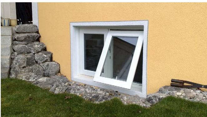
26 Druckwasserdichte Fenster
